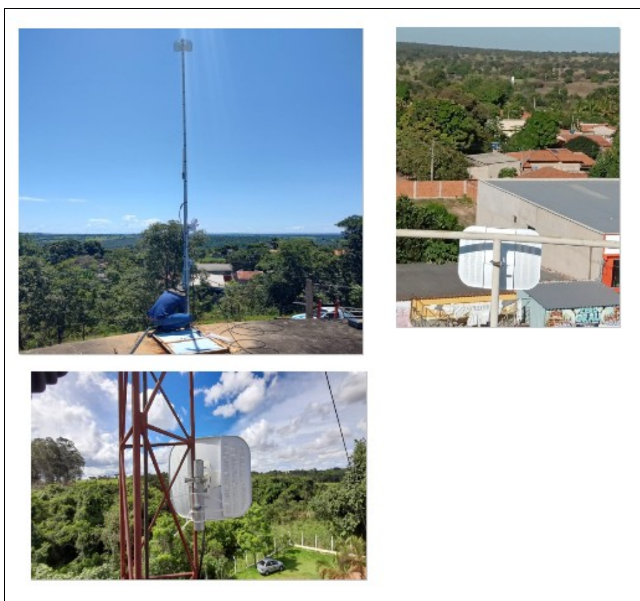
Figura 6. Instalação dos rádios utilizando a estrutura da Saneago
