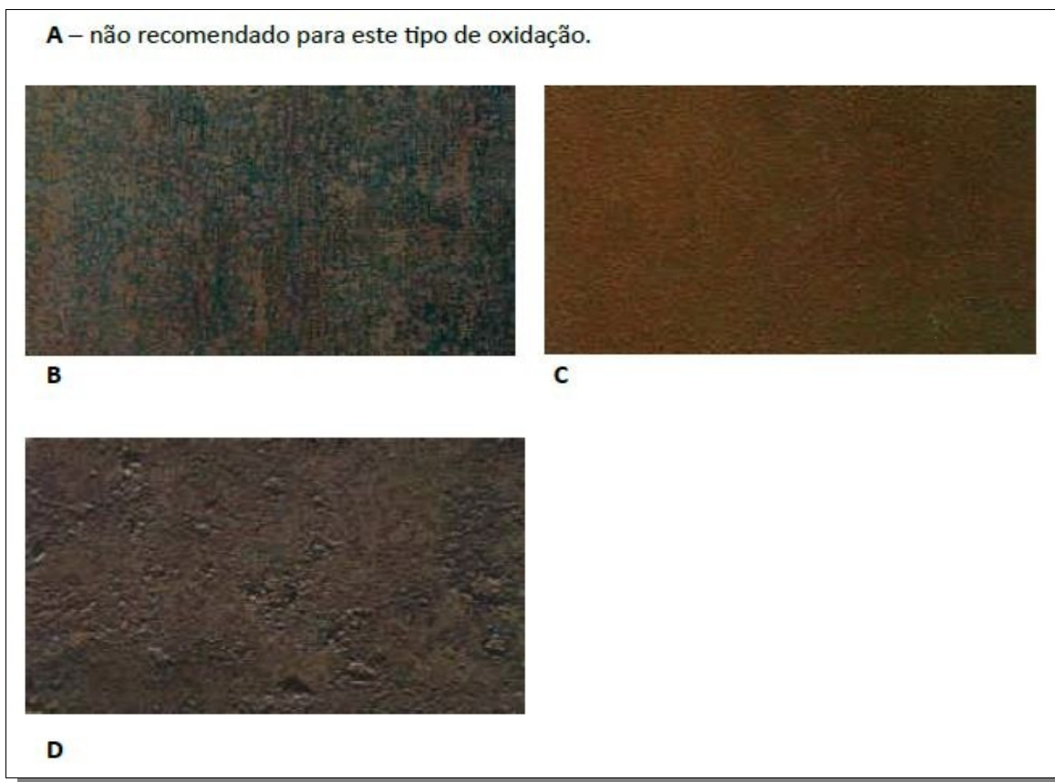
Figura 26 – Graus de oxidação não recomendados
