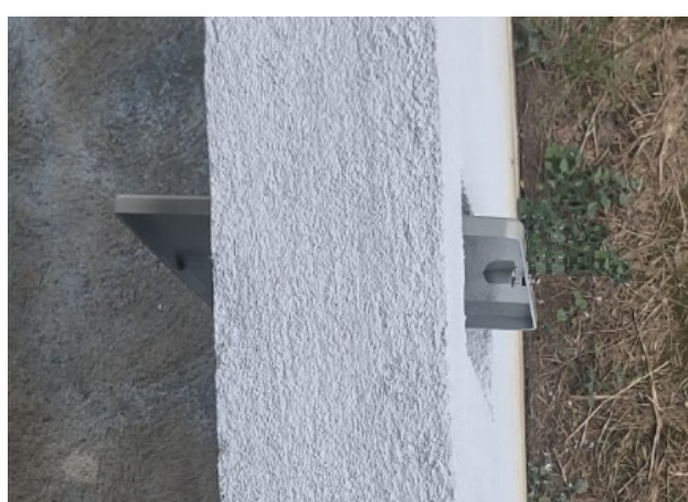
Imagem 6: vista superior de uma mureta (2)
