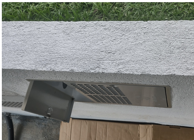
Imagem 5: vista superior de uma mureta (1)
