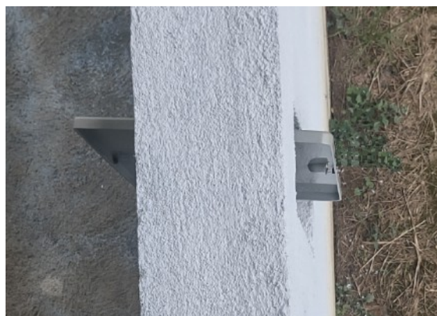
Imagem 6: vista superior de uma mureta (2)
