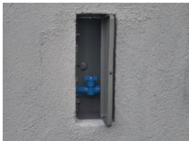
Imagem 4: portas do registro aberto no fundo (acesso interno)
