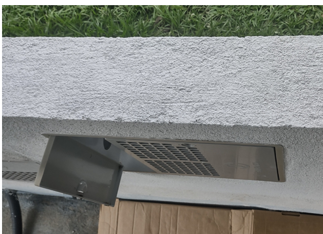
Imagem 5: vista superior de uma mureta (1)
